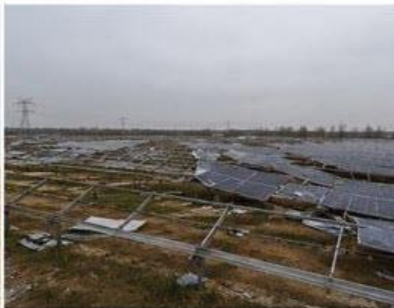
6. 大范围组件损毁，电站发电能力严重下降
