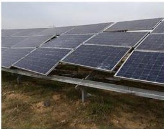
4. 多个组件松动、移位或部分脱落
