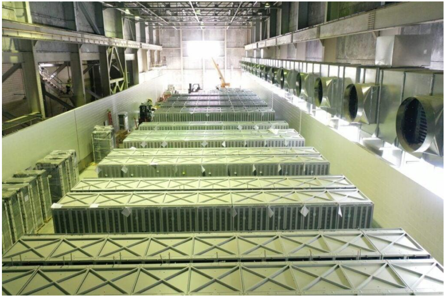
用于MOSS300项目的LG Energy Solution TR1300型电池架
